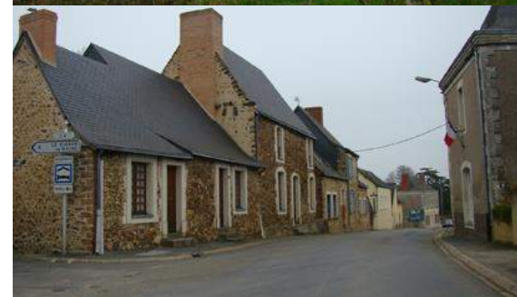
Traitement des franges urbaines en limite de bourg en rupture avec le bourg ancien de Ruillé Froid Fonds
