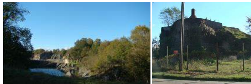
Carrière et four à chaux à Bouère
